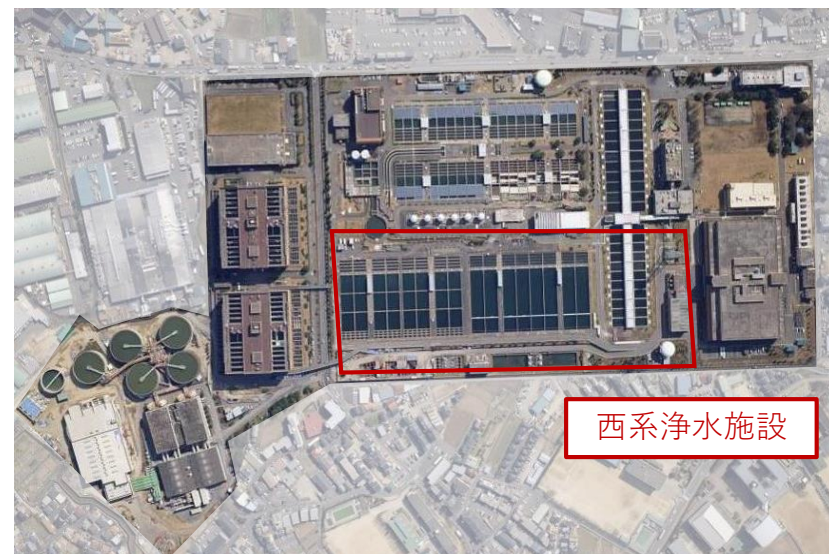
村野浄水場全景
