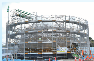
災害に対する安全性の強化のためのバイパス配水管の整備(立坑の築造)
