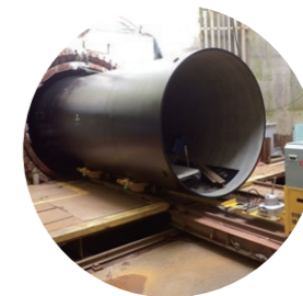
シールド工法による大容量送水管の整備(铸铁管の配管)
