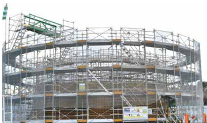
災害に対する安全性の強化のためのバイパス配水管の整備(立坑の築造)
