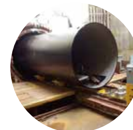
シールド工法による大容量送水管の整備(铸铁管の配管)
