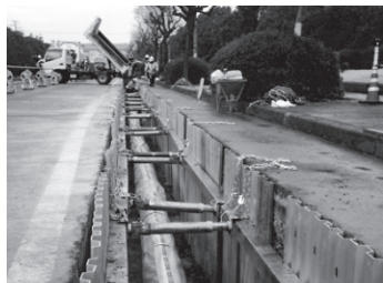
管路の更新・耐震化
