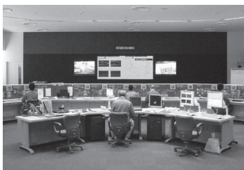
送水管理センター（市町村 への送水状況を24時間体 制で集中的に監視・制御）
