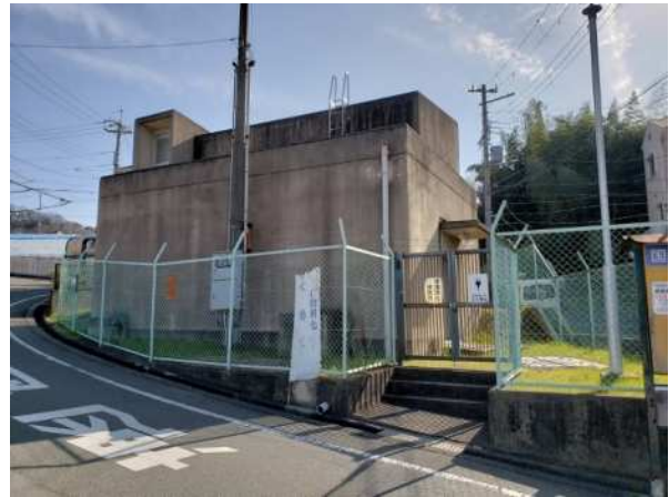
【東春日台ポンプ場】
