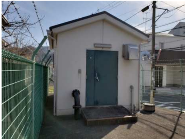
【田辺ポンプ場】
