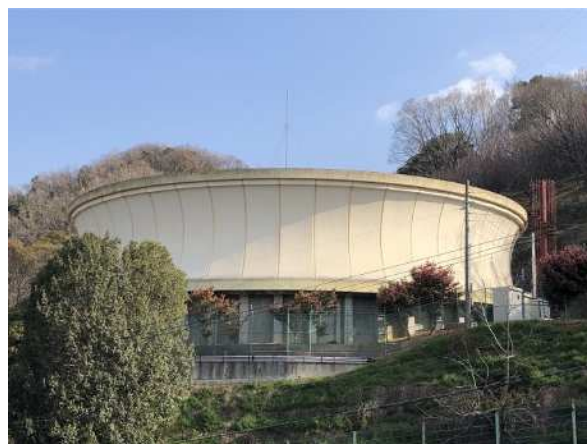
【新安堂配水池】
