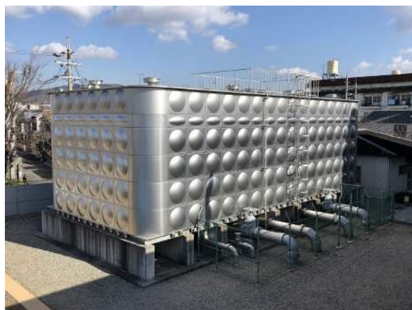
【玉手浄水場第1浄水池】
