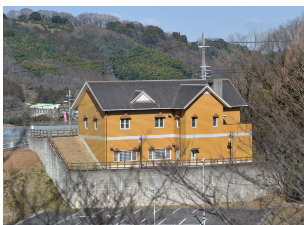
【公園ポンプ場】
