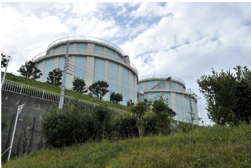
【金剛東配水池】
