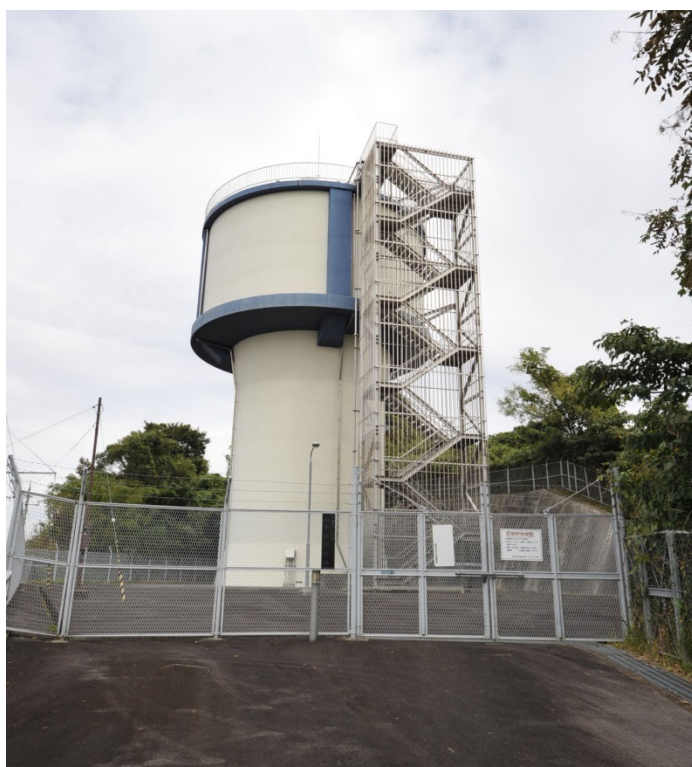
【山中田配水池】
