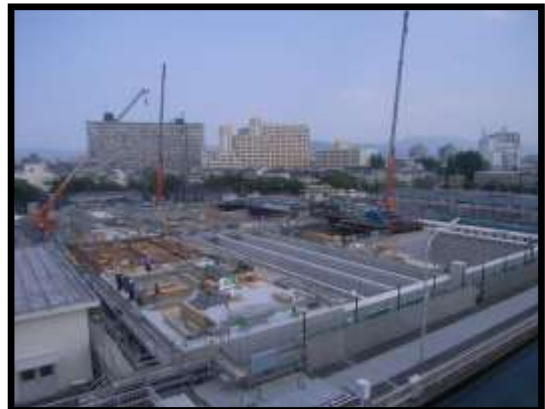
沈澱池更新工事 (大庭浄水場)
