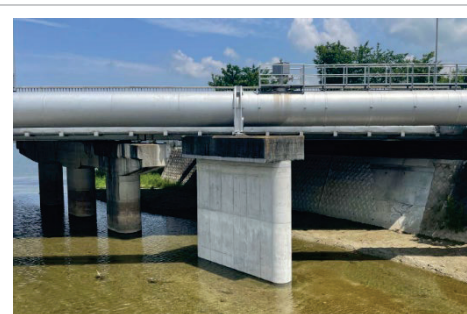
狭山池橋水管橋
