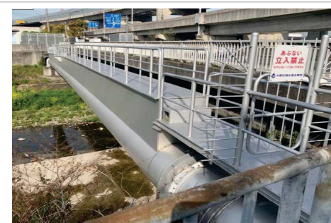
室堂大橋水管橋
