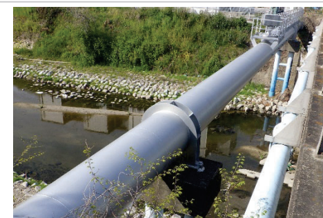
泰成橋水管橋
