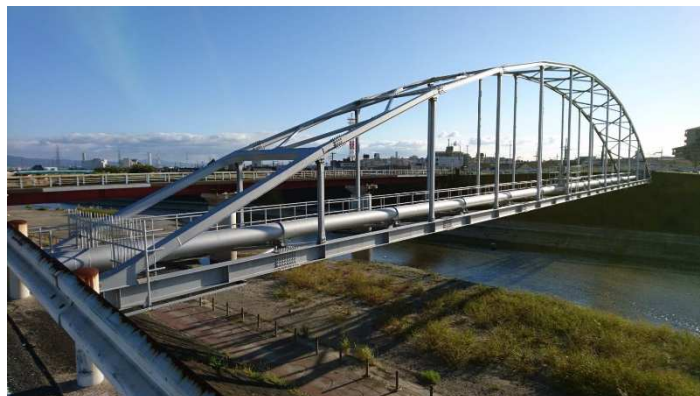
山科水管橋(茨木市)
