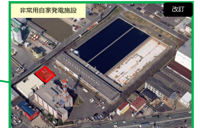
非常用自家発電施設 八尾ポンプ場 ◇耐震補強 ◇配水ポンプ更新 ◇非常用自家発電施設
