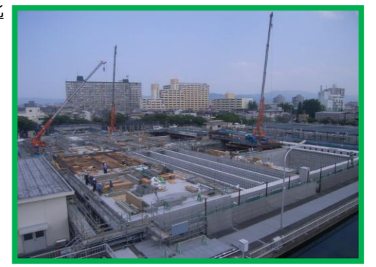
大庭浄水場 20万m 3 /日規模の沈澱池を耐震化 ◇沈澱池更新 ◇ポンプ施設更新
