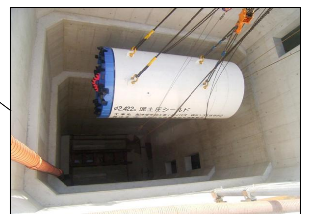
バイパス配水管の施工 大庭～忠岡 (発進立坑における掘進機搬入状況)
