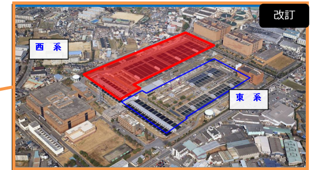
村野浄水場 浄水施設の更新
