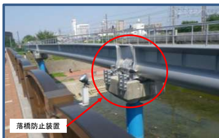
図3-22 水管橋耐震化の例
