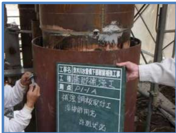
橋脚補強鋼板取付
