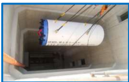
図 3-18 バイパス配水管の整備の例
