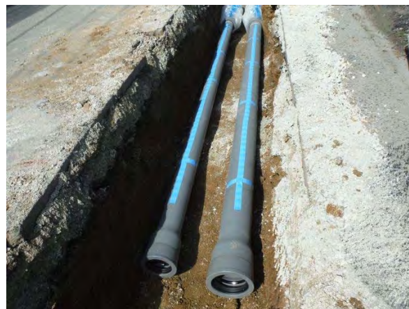
図-5.3.2 耐震管(GX管)布設状況(全景)
