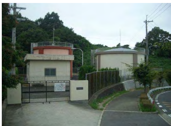
図-2.2.11 さくら坂低区配水池
