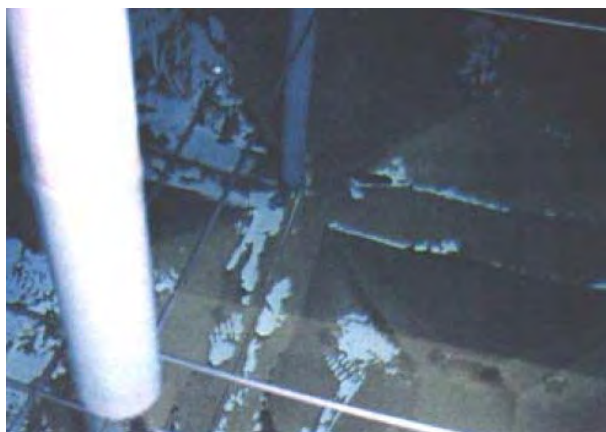
〔貯水槽内の沈殿物〕
