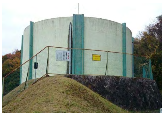
図-5.4.3 機械化警備状況 (大宝高区配水池)
