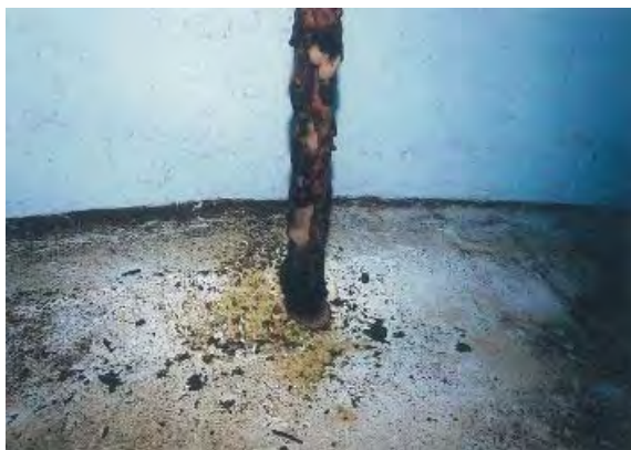
図-4.4.1 池内越流管付近（清掃前）
