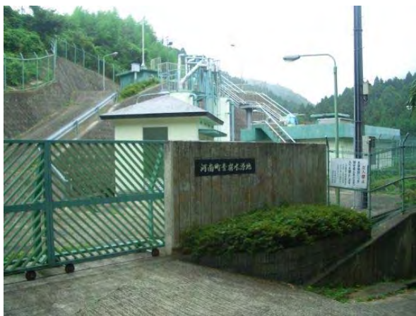
図-2.2.7 青崩水源地全景
