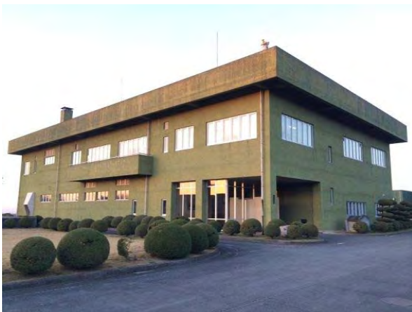
図-4.1.1 日野浄水場水質検査室 (河南水質管理ステーション)
