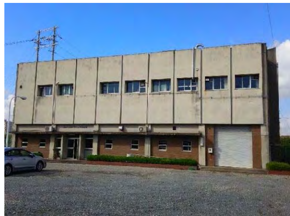
図-4.1.2 玉手浄水場水質検査室 (河南水質管理ステーション)
