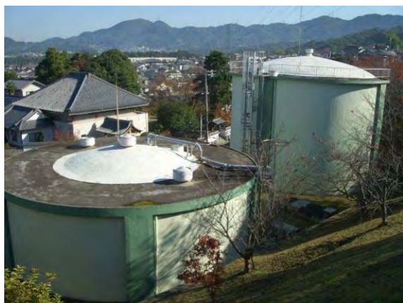
図-2.2.9 大宝低区配水池
