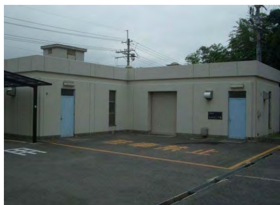
図-2.2.14 白木加圧ポンプ場
