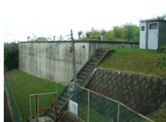
図-2.2.13 馬谷配水池
