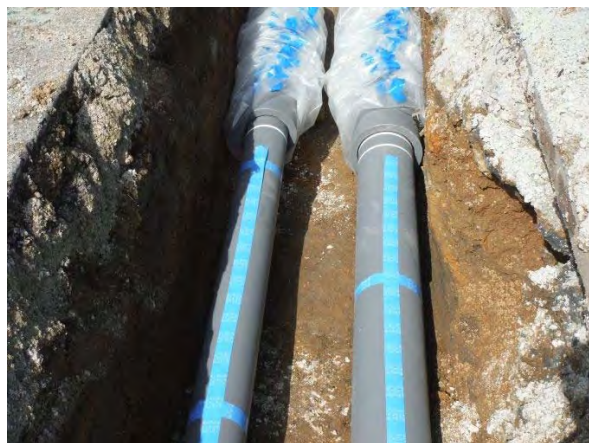
図-5.3.1 耐震管(GX管)布設状況
