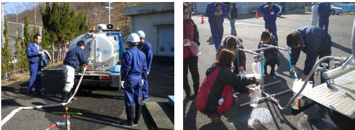
図-5.4.4 大阪広域水道企業団と河南ブロック 10 市町村の震災対策合同訓練状況
