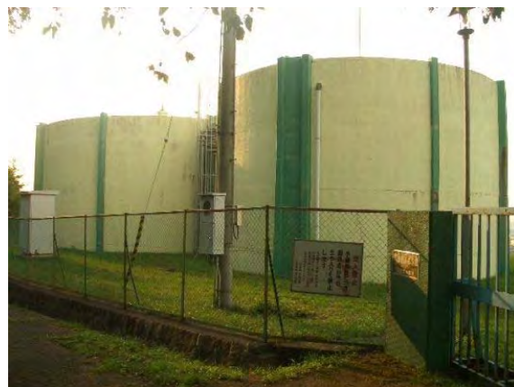
図-2.2.10 大宝高区配水池
