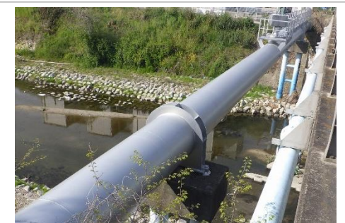
泰成橋水管橋
