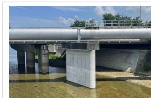
狭山池橋水管橋
