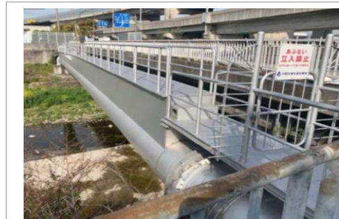
室堂大橋水管橋
