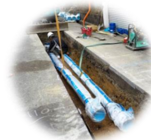
地震に強い管路の整備
