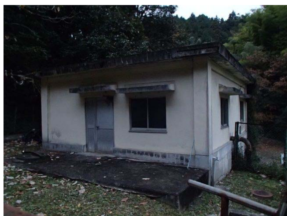
甘南備受水場
