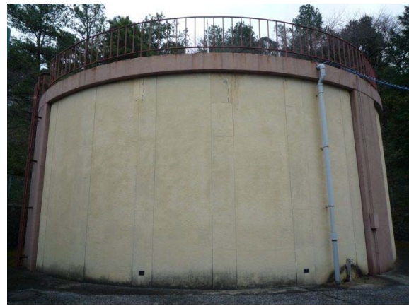
水分低区配水池
