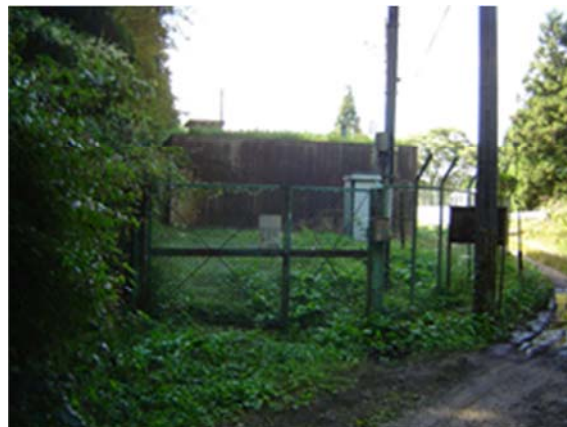
千早第3配水池
