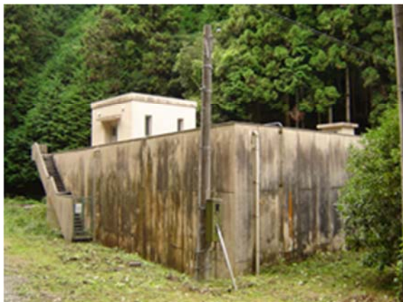
上東阪配水池
