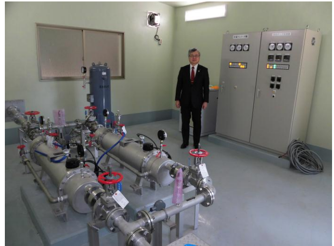
〔葛畑ポンプ場内部〕
