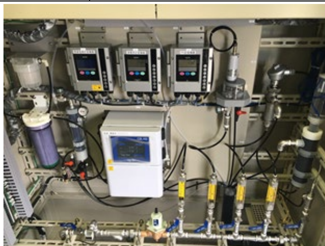
図-9 連続自動測定機器（水質モニター）
