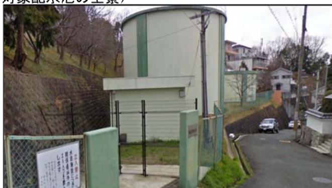
<大宝低区配水池 2池>
