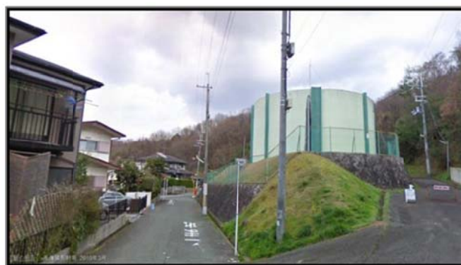
<大宝高区配水池 2池>
