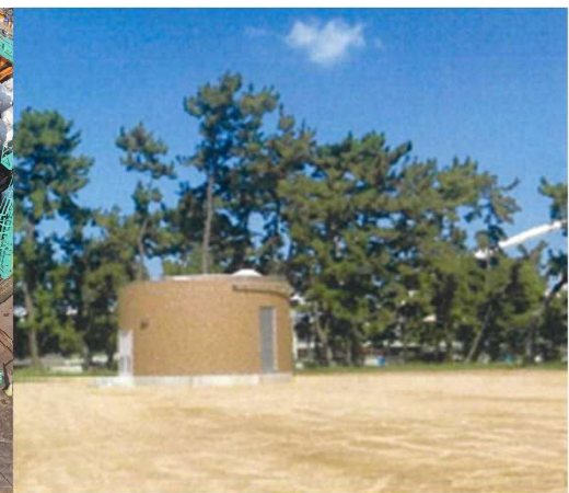
浜寺公園立坑（完成）
