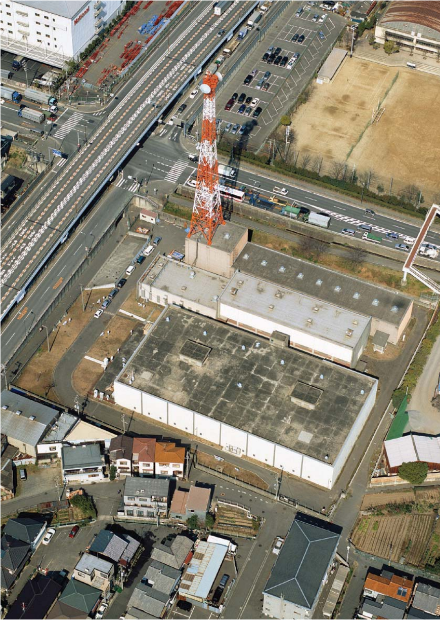
●四條躰ポンプ場
