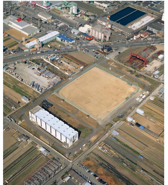
●藤井寺ポンプ場
