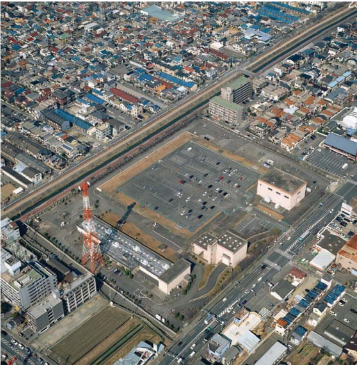
●枚岡ポンプ場
