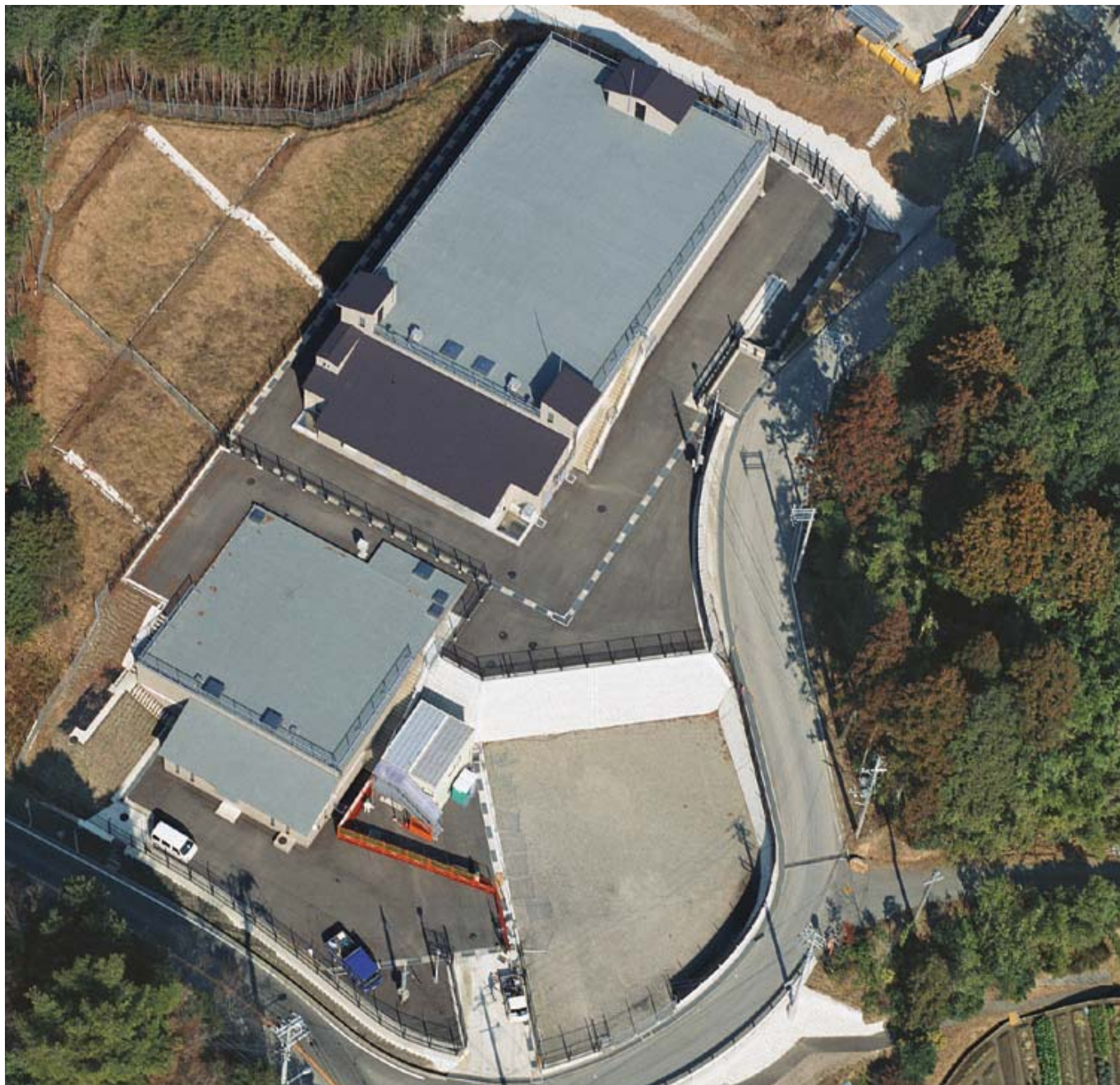
●多留見浄水池
