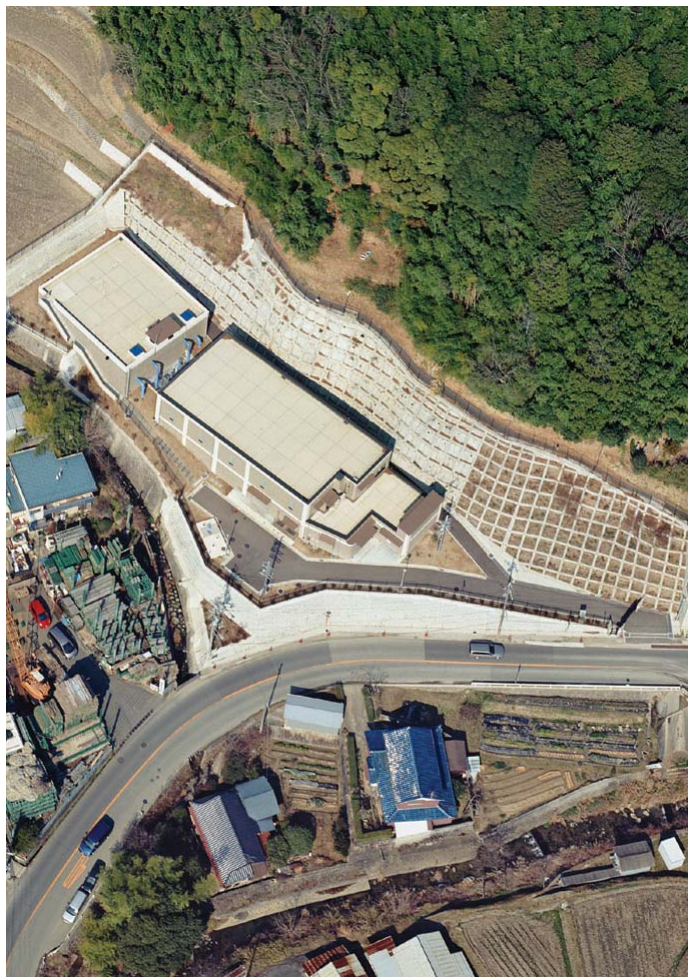
●北部第2(佐保)ポンプ場
