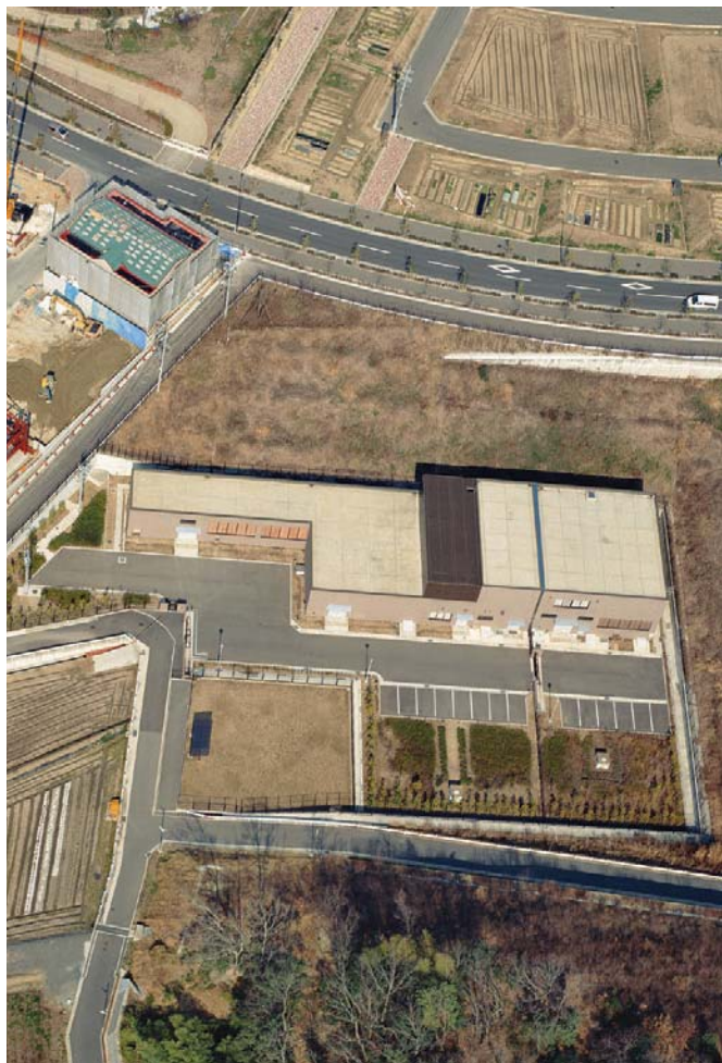
●北部第1(彩都)ポンプ場
