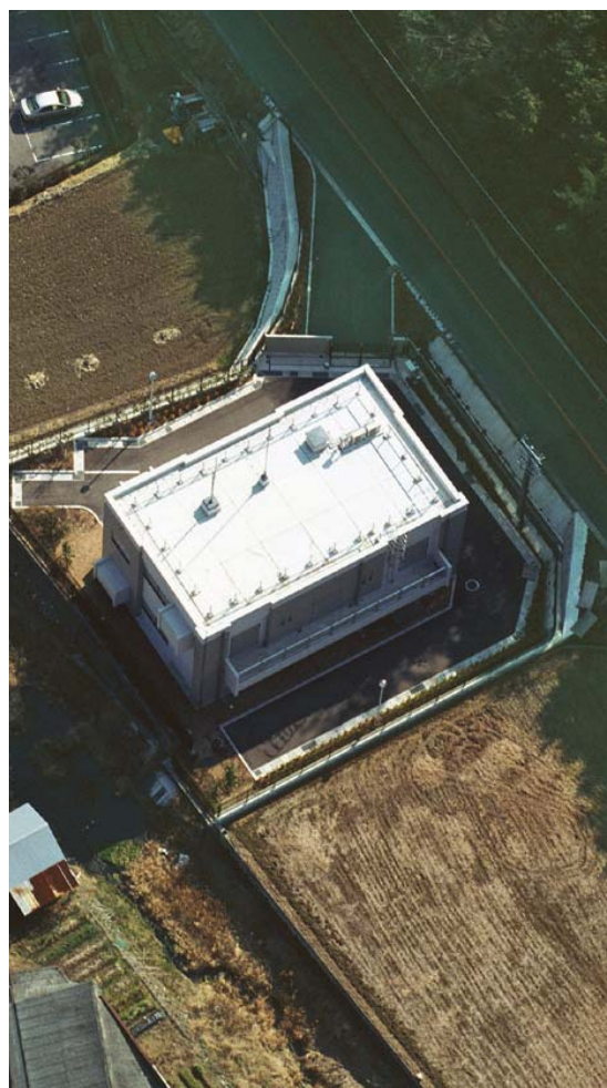
●北部第4(野間口)加圧ポンプ場
