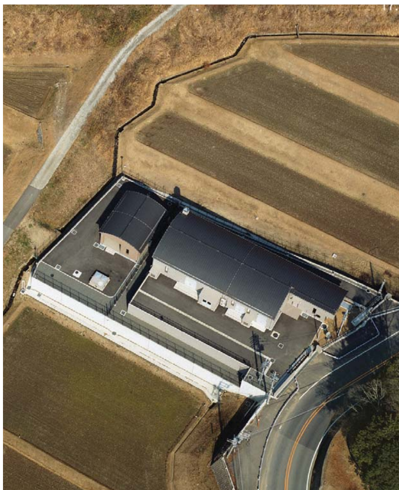
●北部第3(泉原)ポンプ場
