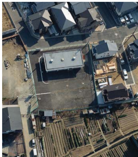
●堺加圧ポンプ場
