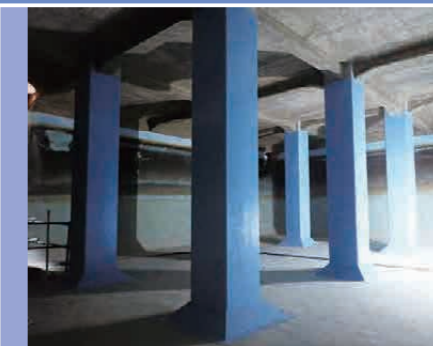
浄水池の耐震補強工事
