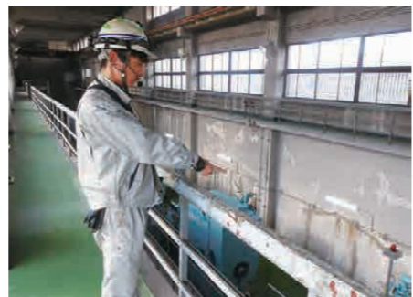
工業用水道施設における維持管理
