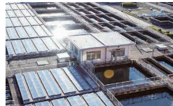
太陽光発電設備
