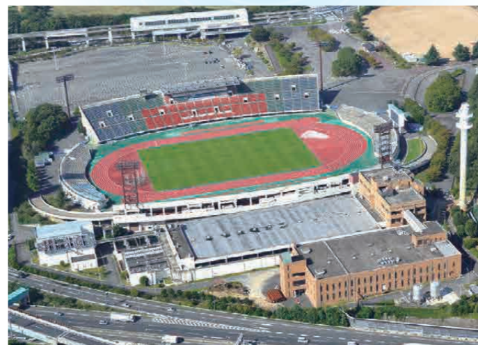
万博公園浄水施設
