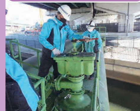
水道管の維持管理作業(弁点検)
