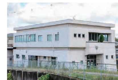
板屋橋浄水場
