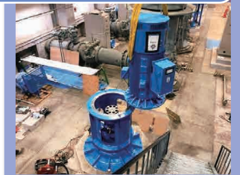
送水ポンプ設備の更新工事
