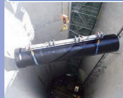
送水管の布設工事
