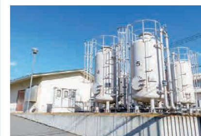
道明寺浄水場
