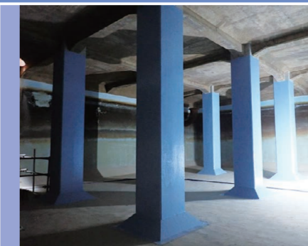
浄水池の耐震補強工事
