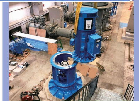
送水ポンプ設備の更新工事
