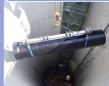
送水管の布設工事
