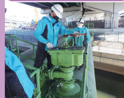
水道管の維持管理作業(弁点検)
