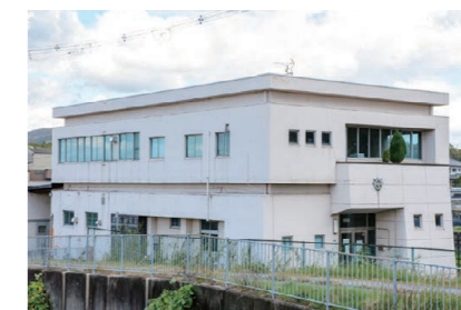
板屋橋浄水場
