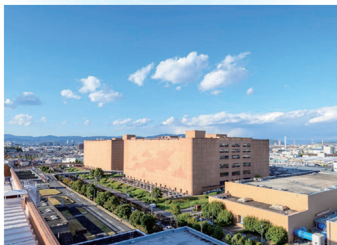
階層系浄水施設
