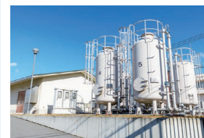
道明寺浄水場
