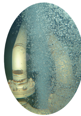
オゾン接触池
