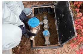
水道メーターの交換
