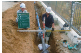
水道管の布設・更新
