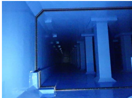
浄水池の耐震補強
