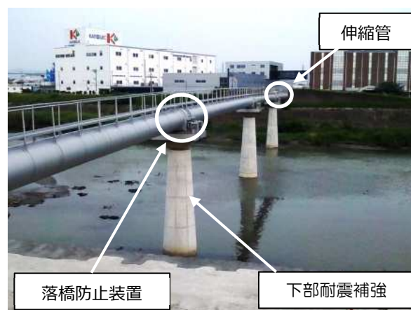
水管橋の耐震化（全景）
