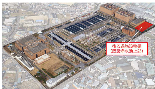
村野浄水場（後ろ過施設）
