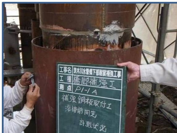
橋脚補強鋼板取付
