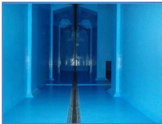
▲浄水池の耐震補強
