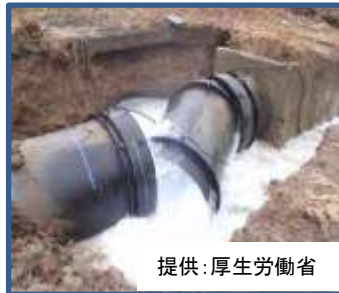
阪神淡路大震災・東日本大震災における水道施設の被害状況
