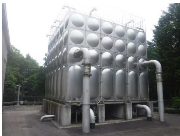
野間口地区施設統廃合事業（豊能水道事業）
