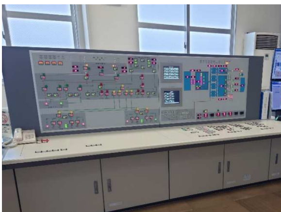
中央監視制御設備の更新（磯島取水場）
