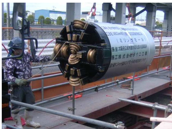
配水管の更新（高槻幹線）
