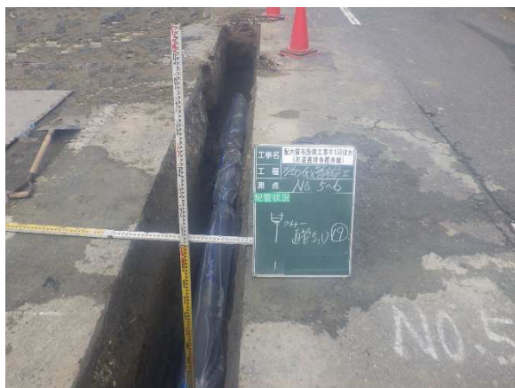
配水管布設替工事（田尻水道事業）
