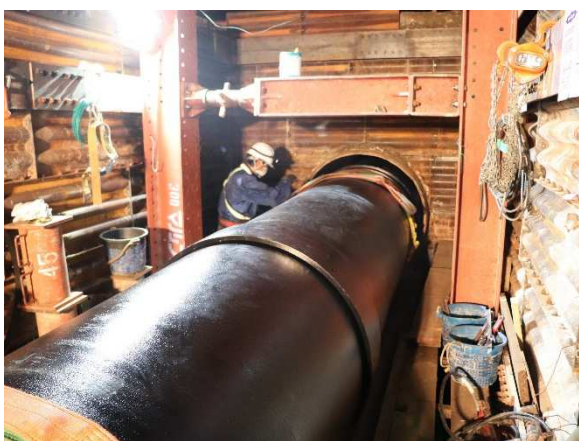
5 拡管路の更新（堺市）
