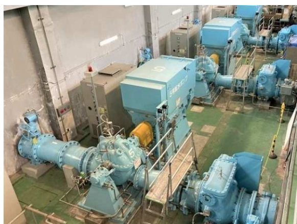
配水ポンプの更新（八尾ポンプ場）
