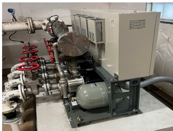
配水ポンプ更新工事（太子水道事業）
