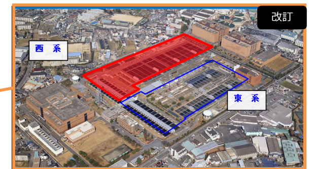
村野浄水場 浄水施設の更新
