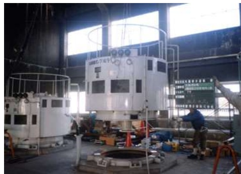
ポンプ設備の点検補修状況
