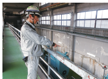
工業用水道施設における維持管理
