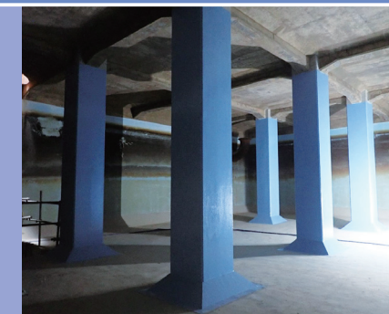
浄水池の耐震補強工事
