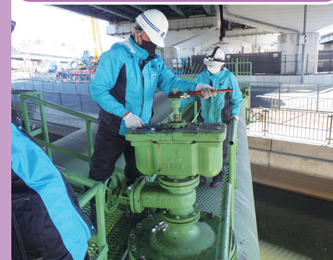
水道管の維持管理作業(弁点検)
