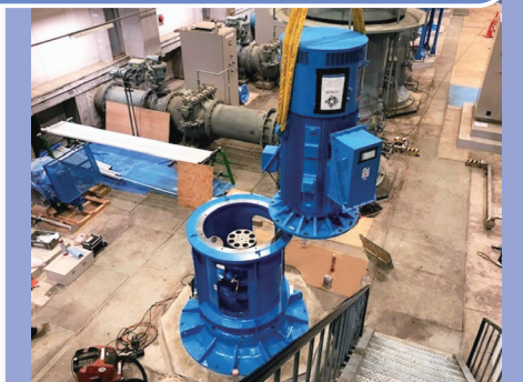
送水ポンプ設備の更新工事
