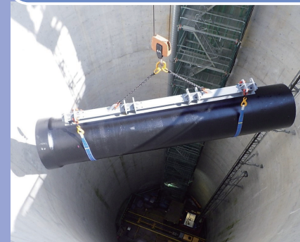
送水管の布設工事
