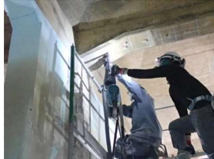
あと施工せん断補強筋施工状況
