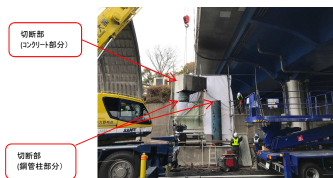
写真-5 橋脚撤去状況(中国道上り線部) ワイヤソー工法による切断・撤去
