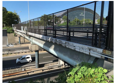
写真-1 水管橋撤去前状況
