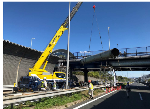
写真-3 上部工撤去状況(中国道上り線部) 大型ラフターによる吊り上げ・撤去
