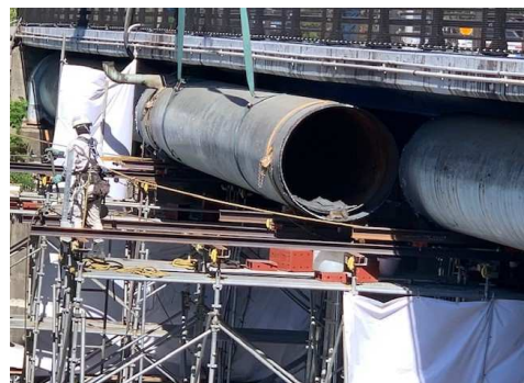
写真-2 上部エスライド状況(中国道上り線部)
