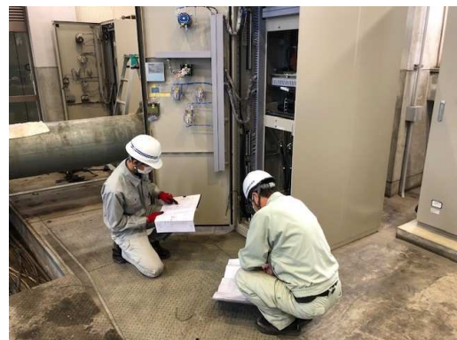
電気盤・高圧ケーブルの接続状況を確認
