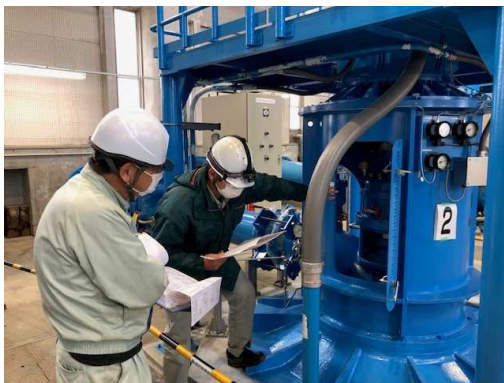
ポンプの据付精度を確認
