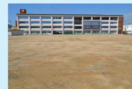
グラウンド整備後（藤井寺中学校）
